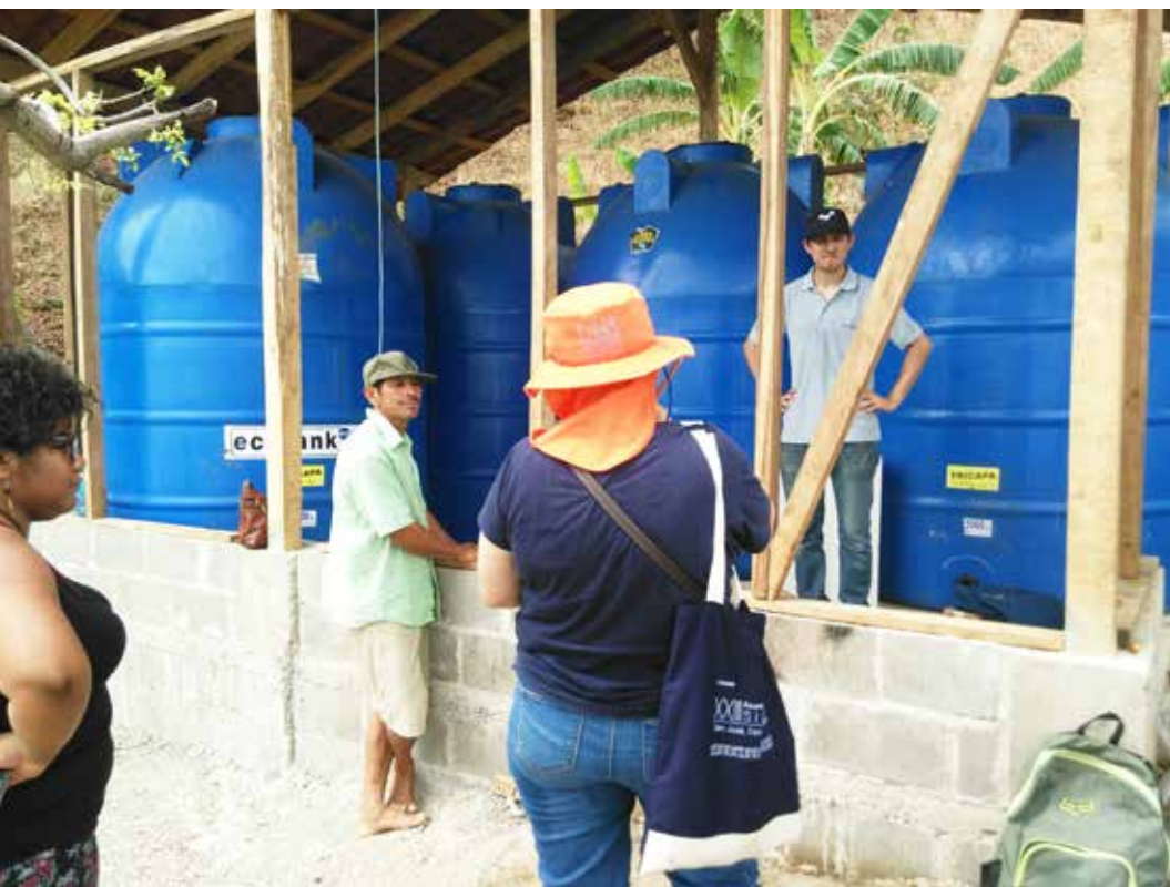
Figura A8. Supervisión de proyecto por parte de la vicerrectoría de extensión de la UNA. NOTA. IMAGEN PROPIEDAD DE LOS AUTORES, TOMADA EL 22 DE MAYO DE 2018.
