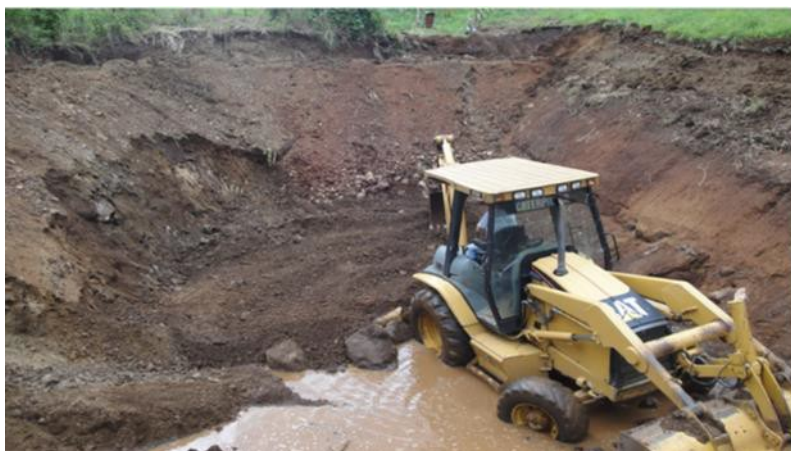
Figura 6: Construcción del reservorio de la familia Díaz, La Esperanza. Fuente: Salinas A., 2009
