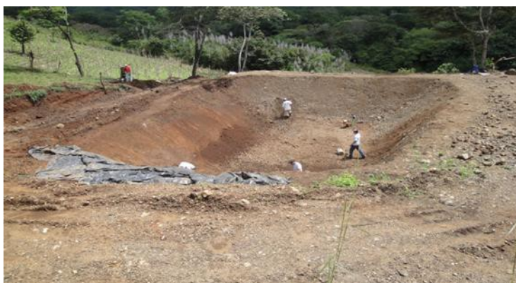
Figura 1. Inicio de la construcción del reservorio tipo represa. La Esperanza de Santa Cruz, Guanacaste. Fuente: Adolfo Salinas Acosta, 2009
