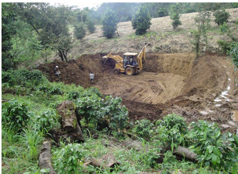
Figura 7. Construcción de Reservorio. Fuente: Adolfo Salinas Acosta, 2009
